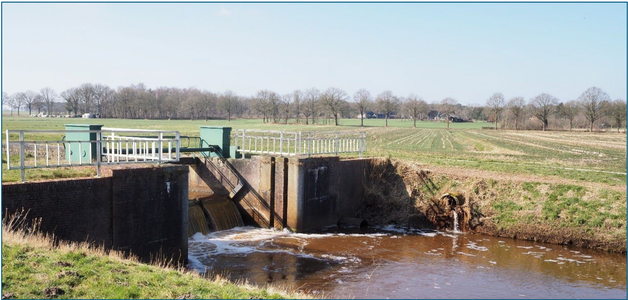
Figuur 4-3 Niet-passeerbare stuw voor vissen in het Voorste Diep in de Bronnegermaden.
