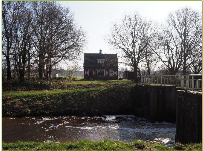
Figuur 6-4 Schutsluiscomplex bij de Bronnegerwatermolen
