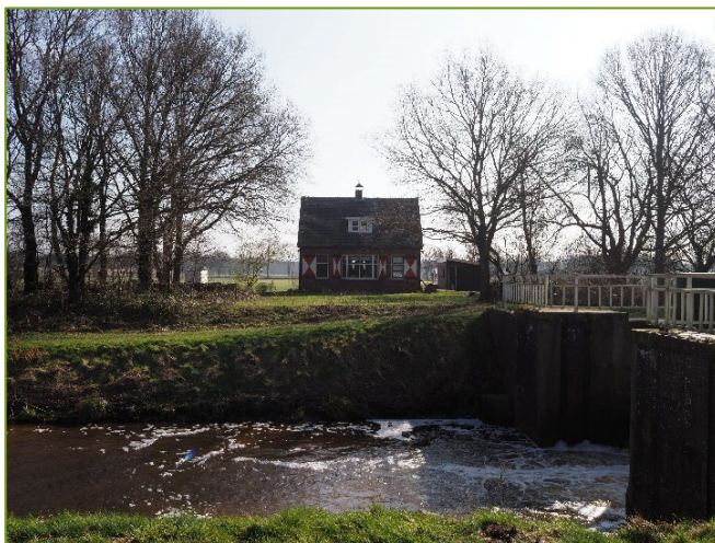
Figuur 6-4 Schutsluiscomplex bij de Bronnegerwatermolen
