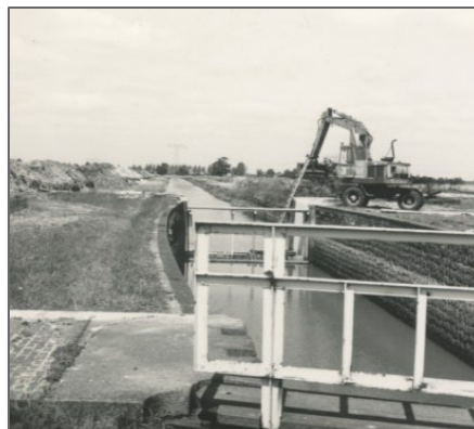
Figuur 6-2 Oude scheepvaartsluis in het Kanaal Buinen-Schoonoord waarin een beweegbare stuw wordt gebouwd (1974).
