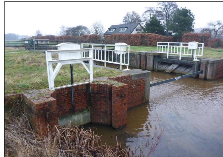
De schutsluis, met voormalige sluiswachterswoning en brugovergang, in 2019
